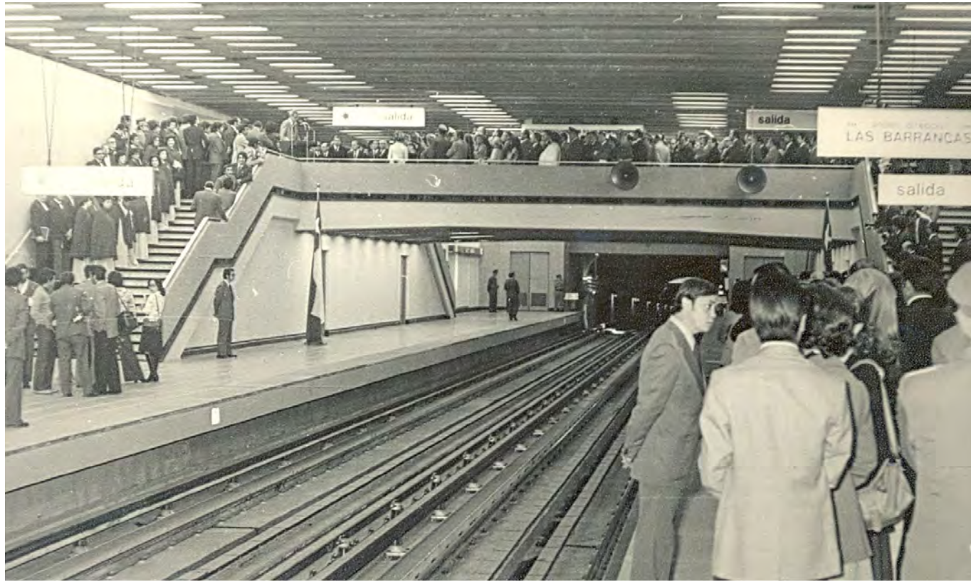
La primera línea del Metro de Santiago fue inaugurada el 15 de septiembre de 1975, por Augusto Pinochet, durante la dictadura militar. Foto: Gentileza de Metro.
