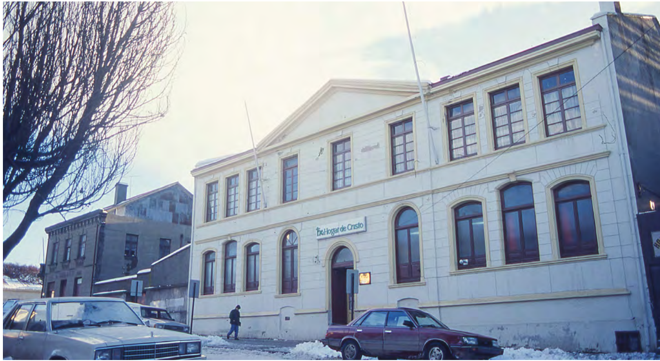
El 5 de abril de 1987 se inaugura el Hogar de Cristo en Punta Arenas en el edificio de calle Balmaceda 736.
